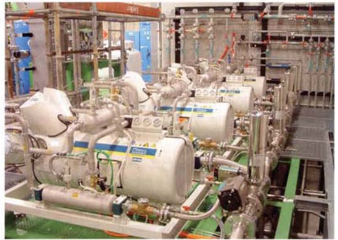
Bild 2: QTOGX 160/80 LM Kompressoren von HAUG direkt neben dem ATLAS Detektor verdichten das C3F8 Kühlmedium von 1 bar auf 16 bar (Bild: CERN)
