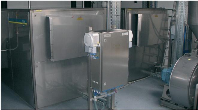
**Auch Schallhauben und Klemmenkästen werden für den Pharmaeinsatz in Edelstahl ausgeführt**
