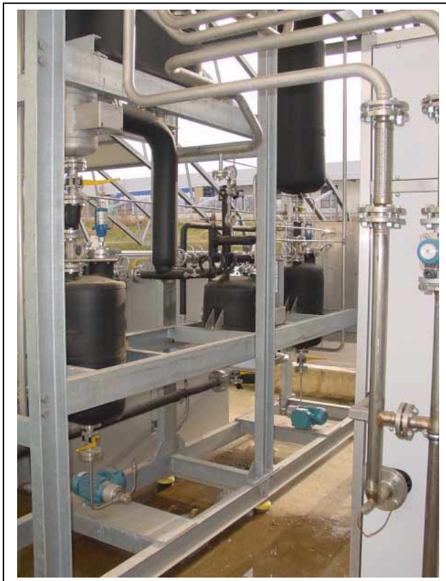
Flüssiggas- u. Pufferbehälter
